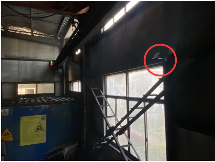
危废库外部监控
