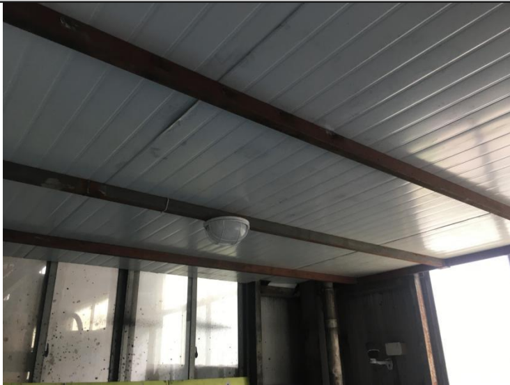
危废库内部监控及防 爆灯
