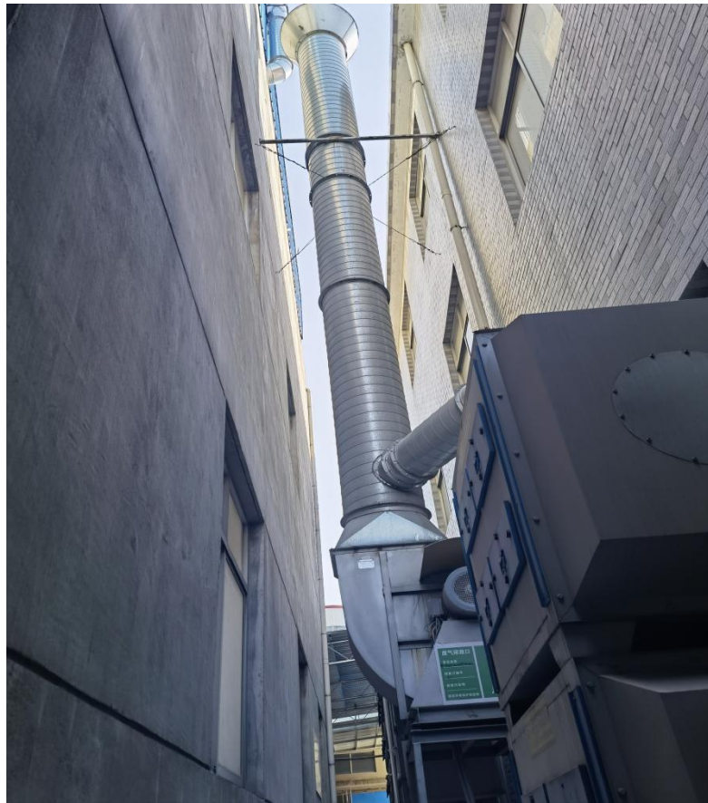
废气处理设施排气筒
