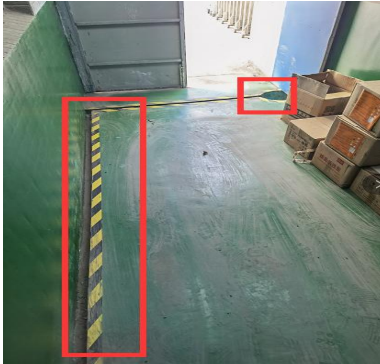
危废库内部环氧及 导流槽、集液池
