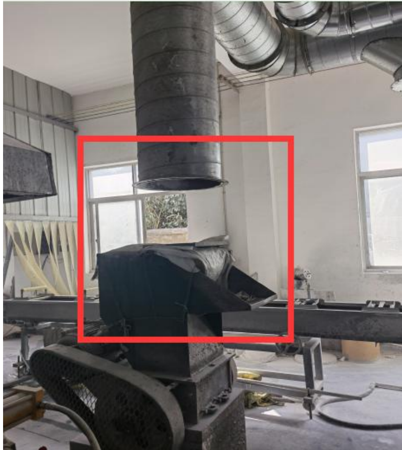
粉碎工段废气收集
