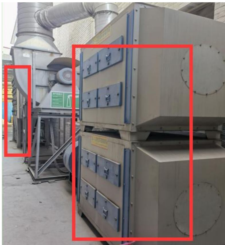
废气处理设施：布袋 除尘装置一套；二级 活性炭吸附装置一 套
