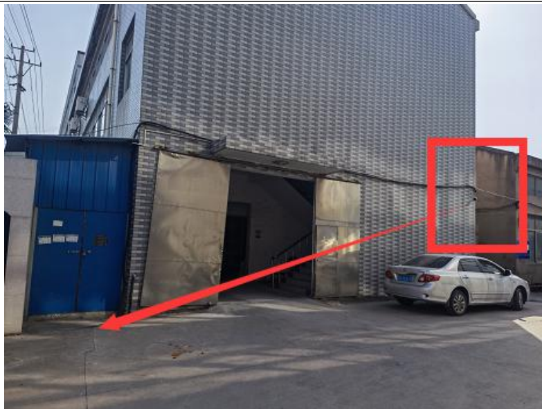
危废库外部监控
